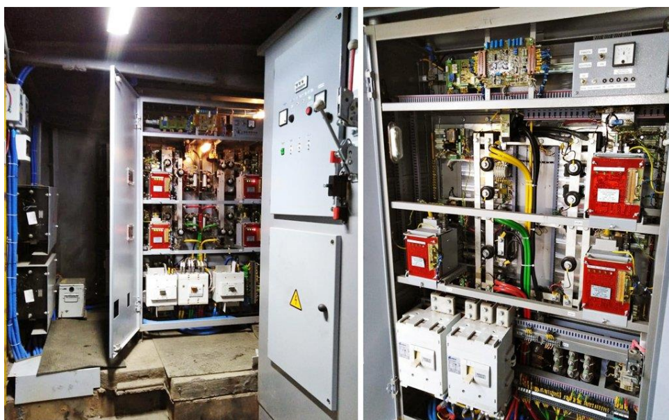
8 Сурет – "Екінші буын" цифрлық ТЖҚ электр энергиясын тұтынуды екі есеге қысқартады (ТЖ–Д жүйесі бойынша ТЖҚ)
