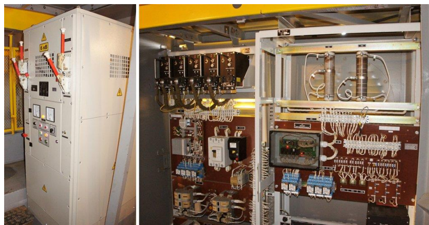
8 Сурет – Сандық ТЖҚ экскаватордың электр жетектерін басқару сапасын едәуір арттырады (ТЖҚ Г–Д жүйесі бойынша)
